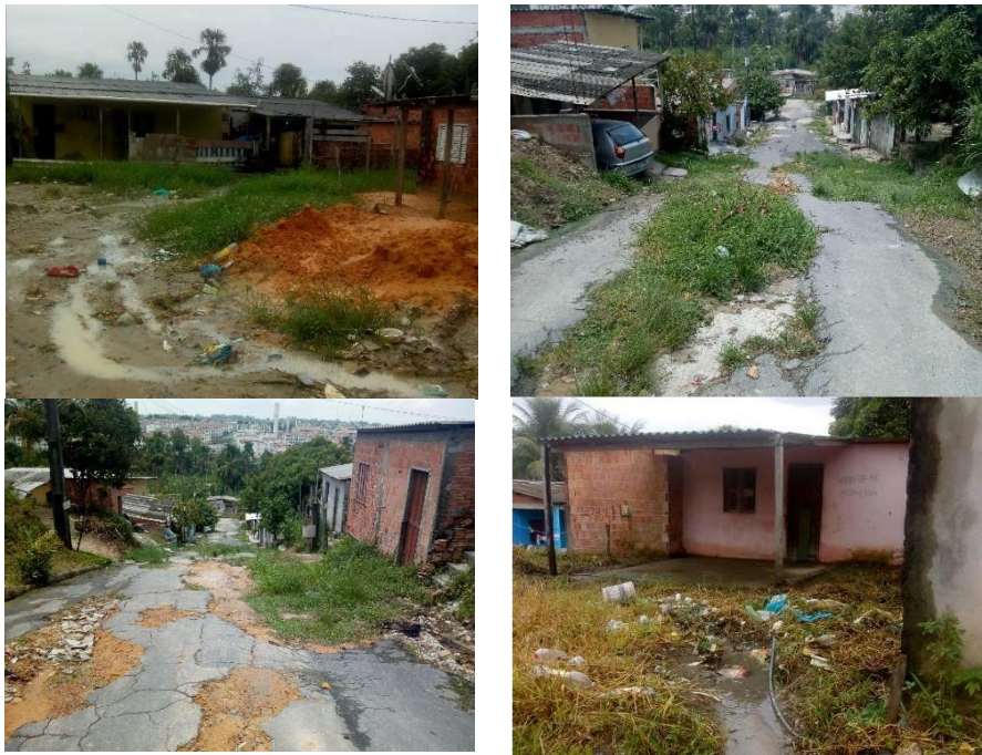
Figura 1, 2, 3 e 4 – Infraestrutura Sanitária, Manaus-AM
