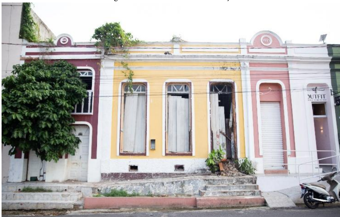
Figura 5: Fachada frontal da edificação
