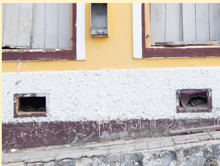
Esquadrias – Porão elevado sem abas de fechamento Fonte: Autora, 2024
