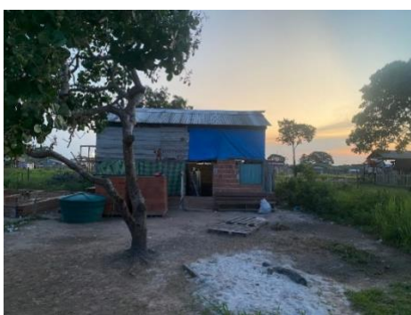
Figura 2: Casa com autoconstrução
