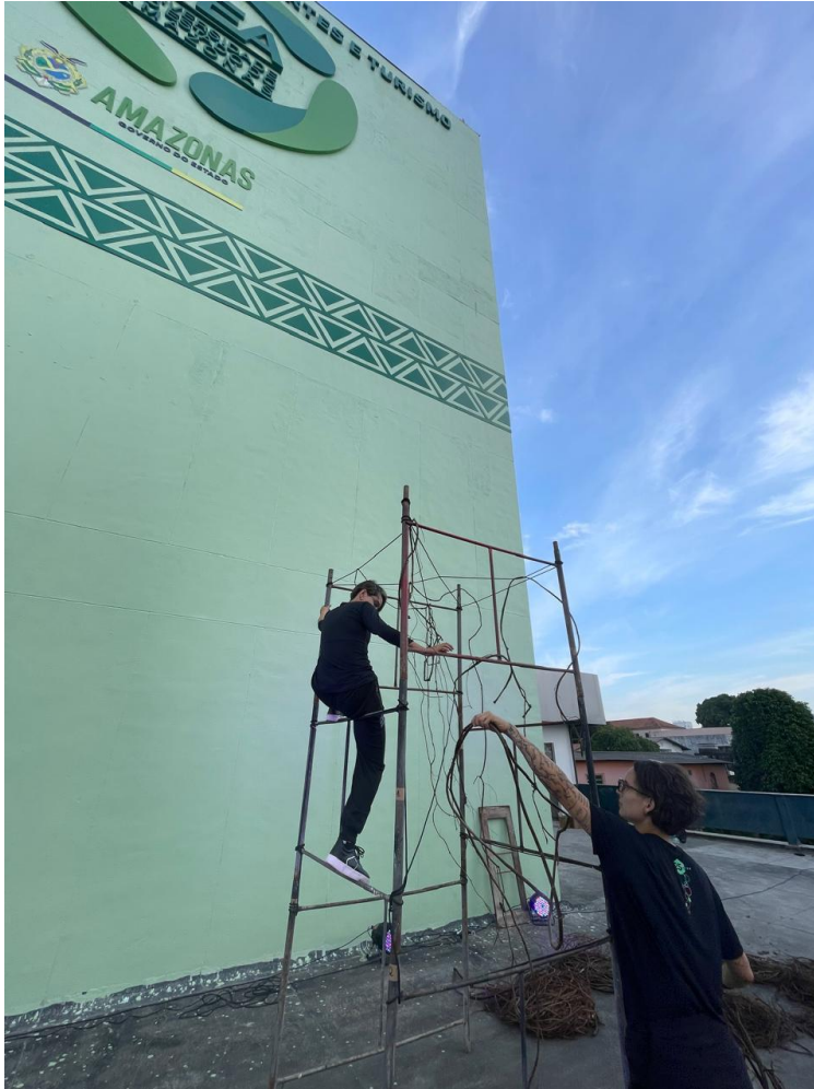
Figura 43. Preparação Memórias do Concreto
