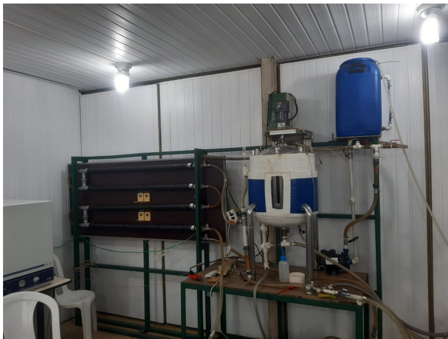
Figura 30: Sistema de Troca Térmica Pronto para a Realização dos Experimentos
