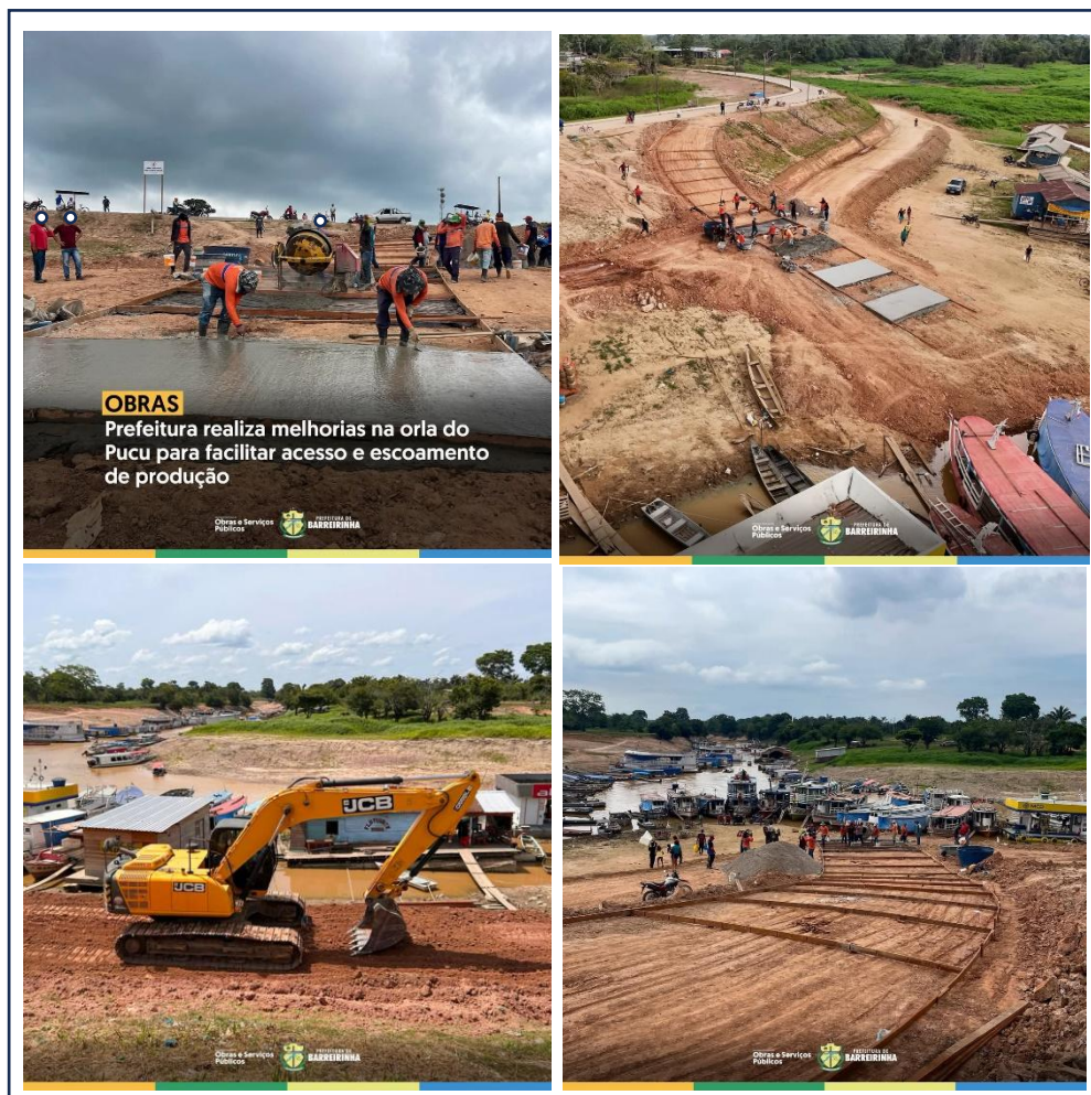
Figura 8 – Obra no Porto (Orla) do Pucu
