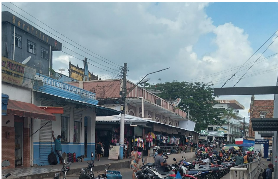
Figura 14 – Fachada do antigo Mercado Municipal
