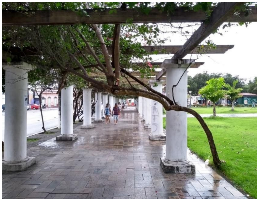
Figura 18 – Falta de manutenção em árvore na Avenida Epaminondas
