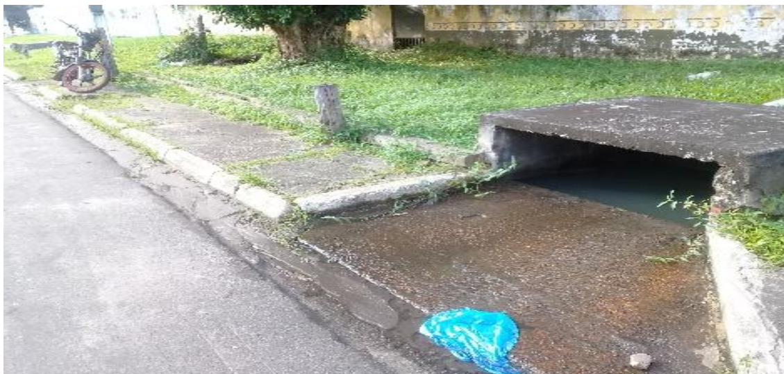
Figura 12 - Derramamento do óleo queimado, causando degradação do solo
