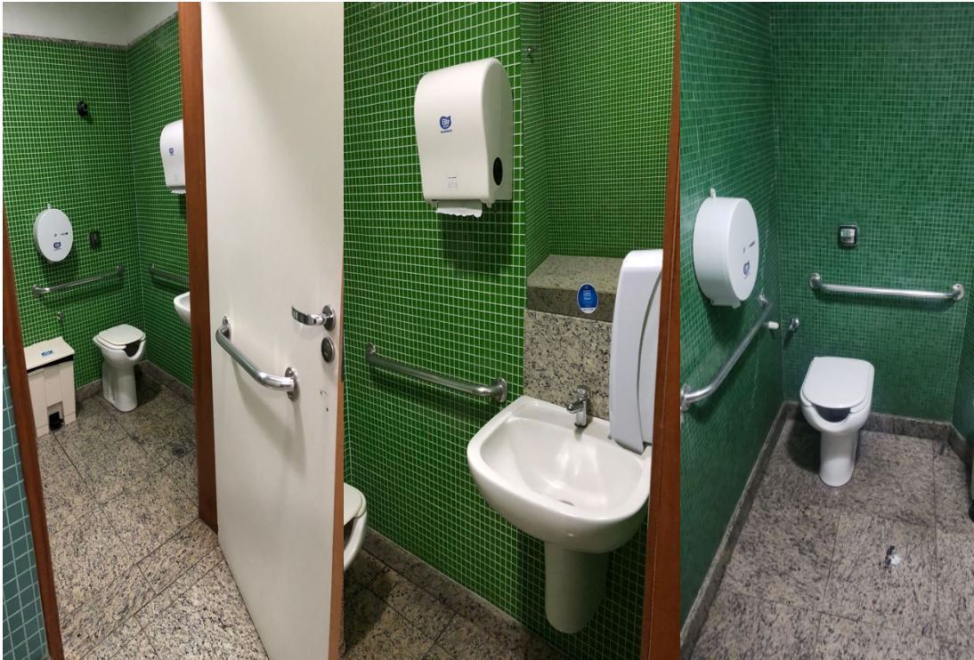
Figura 37 – Sanitários com acessibilidade
