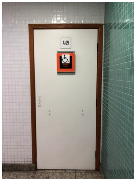
Figura 36 – Sanitário com a sinalização para acessibilidade
