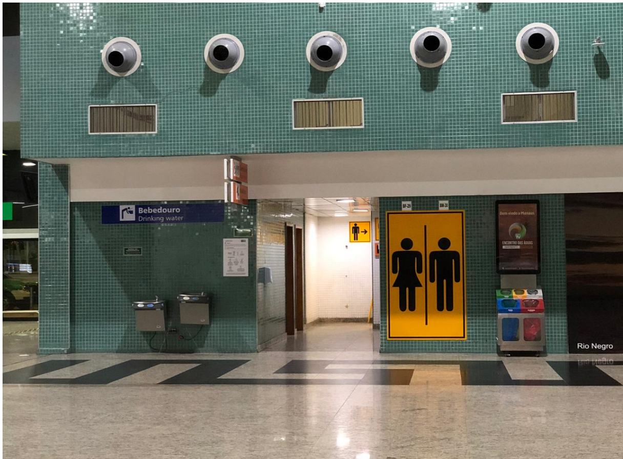
Figura 22 – Área de circulação no segundo andar/pavimento
