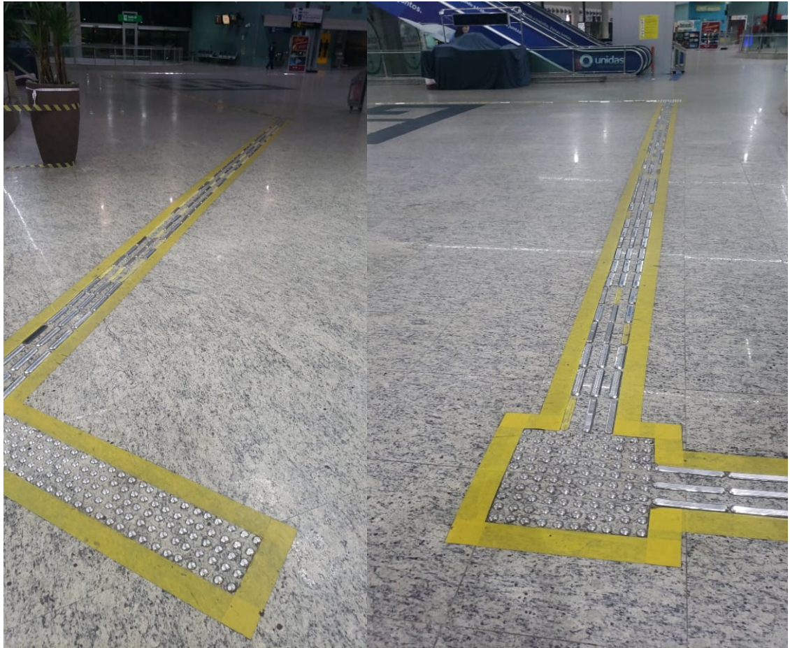
Figura 23 – Sinalização no piso para deficientes visuais
