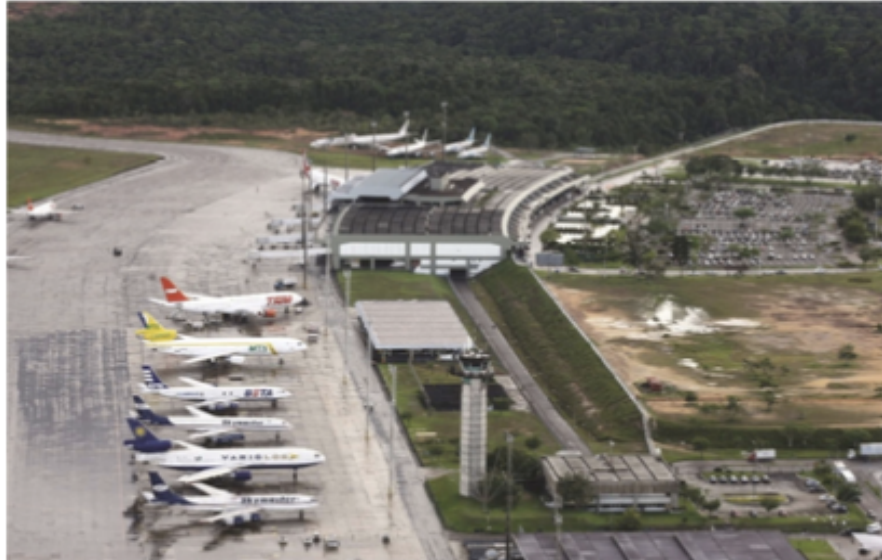
Figura 1 - Vista aérea do Aeroporto Internacional Eduardo Gomes
