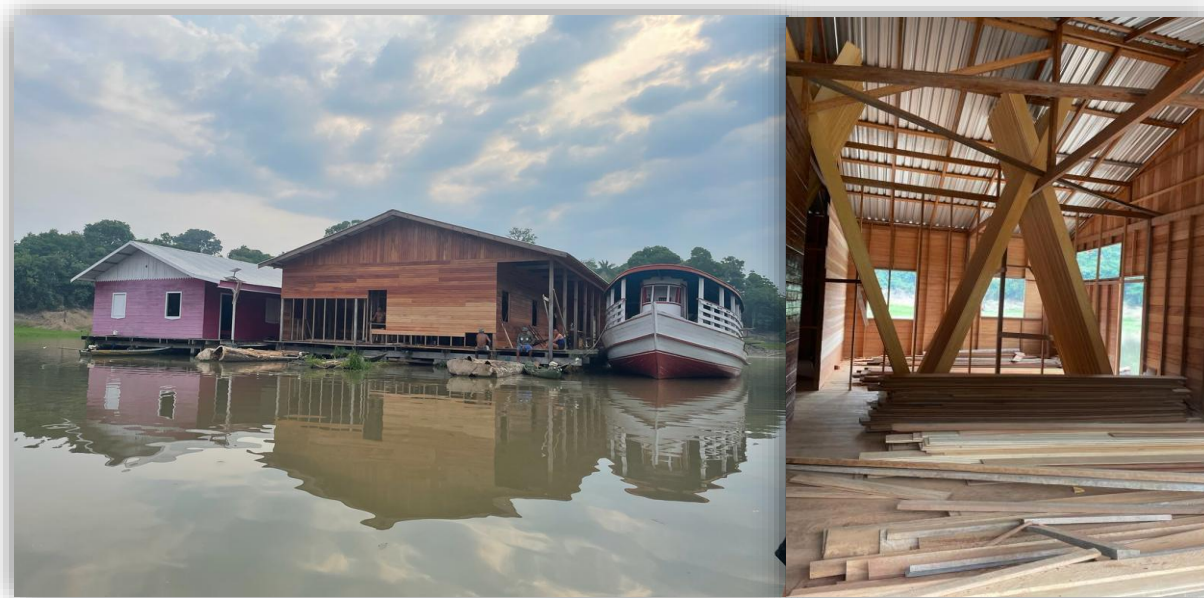
Figura A) Vista do Amazon Apuí Lodge B) Interior em construção.
