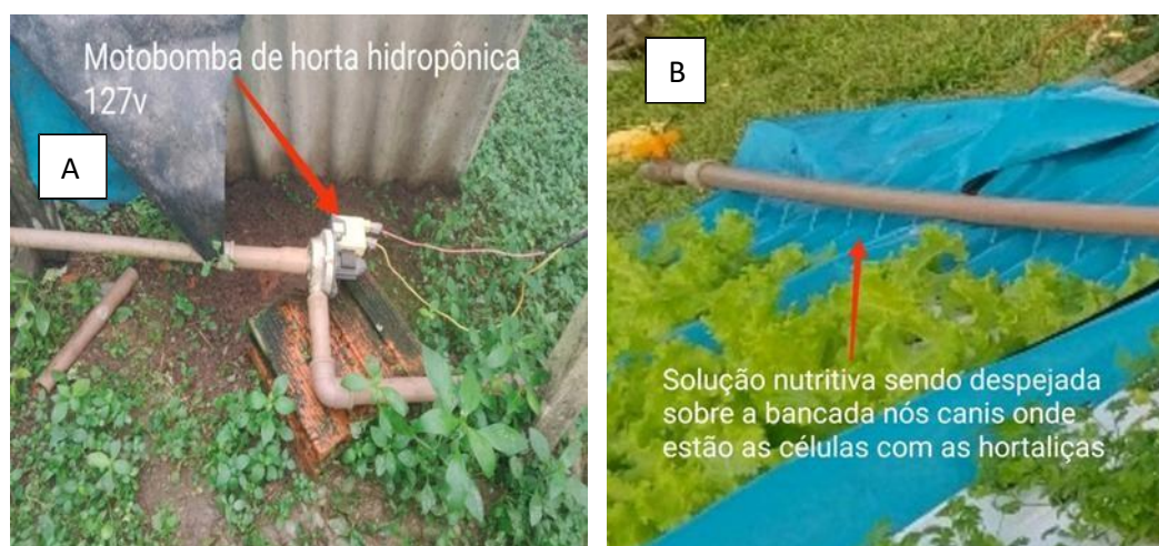
Figura 10. (A) Motobomba utilizada para a circulação periódica da solução nutritiva no sistema hidropônico; (B) Solução nutritiva sendo distribuída sobre a bancada, nos canais onde estão as células com as hortaliças.
