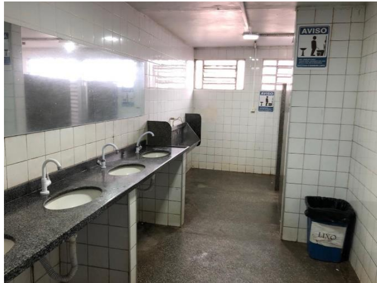
Figura 25. Lavatórios e mictório do banheiro masculino do TRP de Manaus
