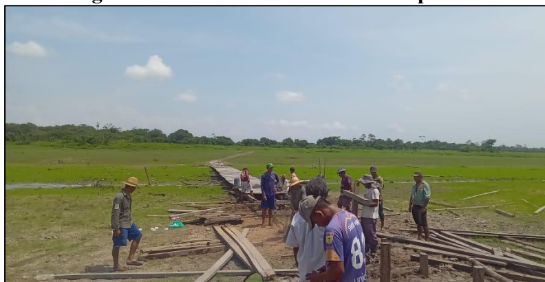
Figura 4: Moradores construindo as pontes.
