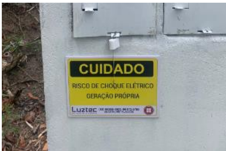
Figura 20 - Placa de sinalização geração própria
