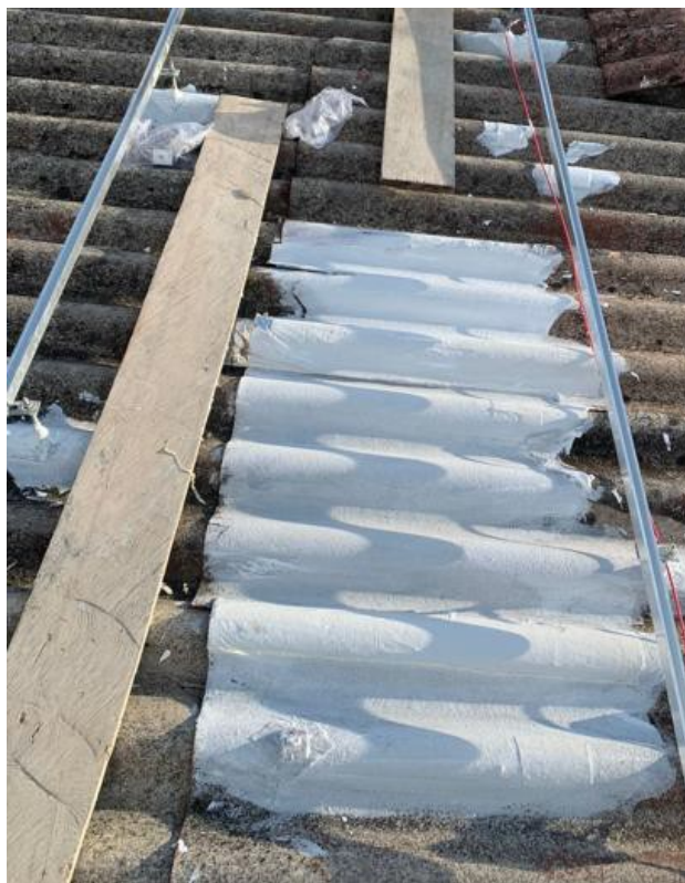
Figura 27 - Reforço de impermeabilização do telhado
