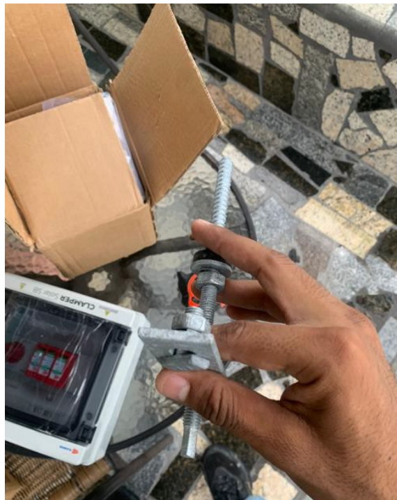
Figura 17 - Inspeção dos fixadores
