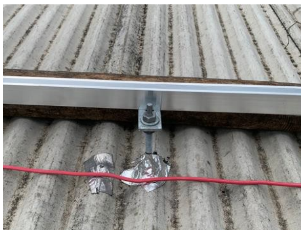
Figura 25 - Fixador instalado em estrutura de madeira com vedação de manta asfáltica
