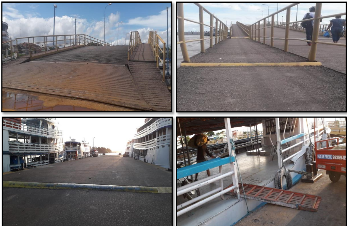
Figura 29, 30, 31, 32 - Rampa; passarela; balsa de acesso; rampa de embarque e desembarque
