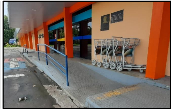
Figura 15- Rampa e porta de entrada
