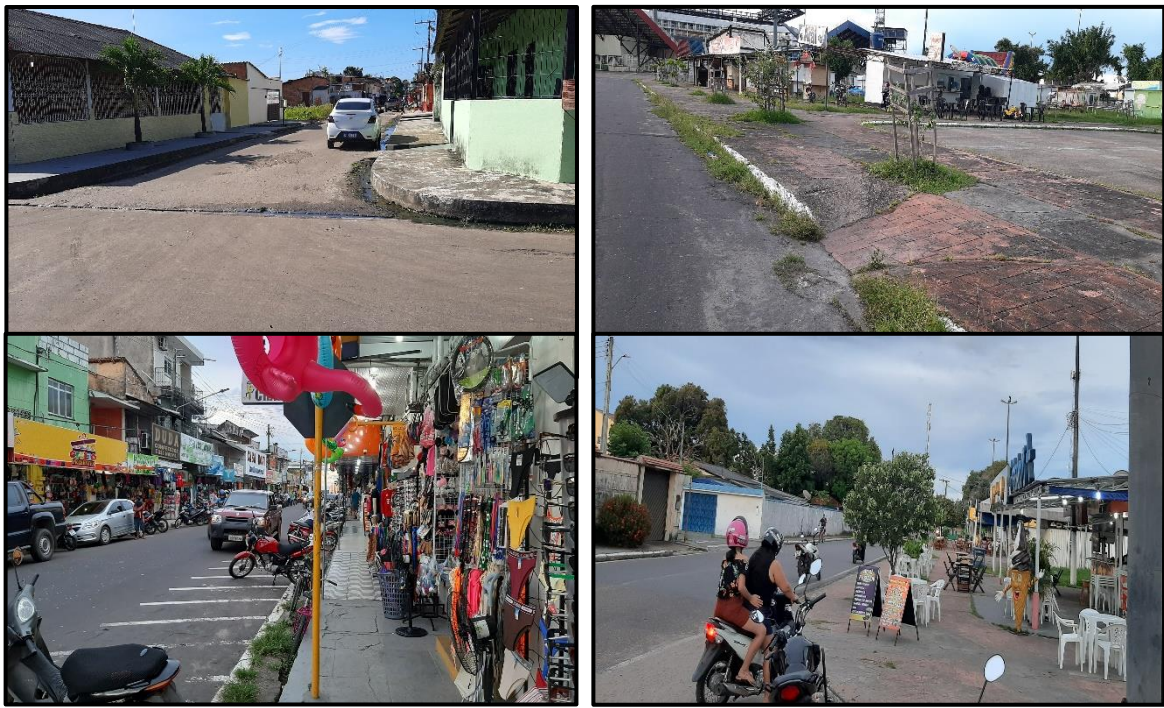
Figuras 2, 3, 4, 5 – Calçadas irregulares; rampa esburacada; calçadas ocupadas pelo comércio
