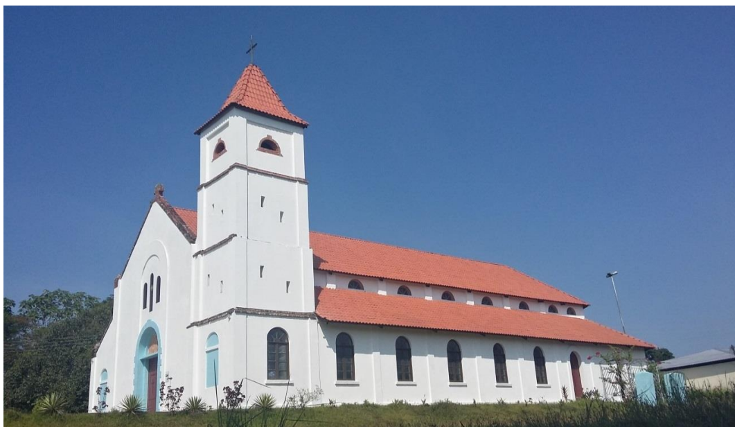
Imagem 09: Igreja da Missão. Fonte cedida do arquivo fotográfico da Escola Estadual Nossa Senhora das Graças localizada na Comunidade da Missão (2015).
