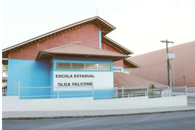
Figura 2 - Fachada da Escola
