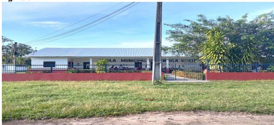
Figura 6: Escola Prédio Novo
