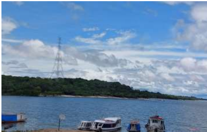
Figura 05: Torres de transmissão de energia do Linhão
