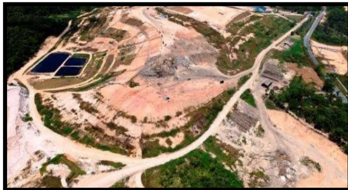
Fig. 01 – Aterro Sanitário em Manaus Fonte: Google
