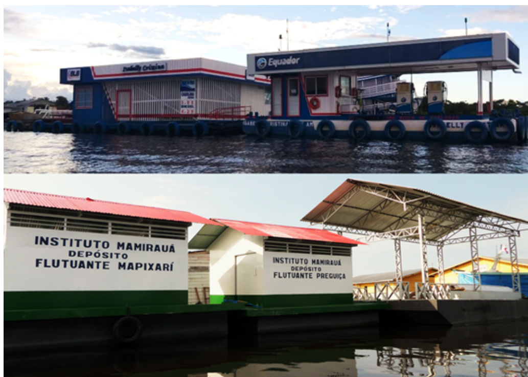
Figura 8 – Flutuantes de ferro no lago de Tefé, um pontão (acima) e outro do Instituto de Desenvolvimento Sustentável Mamirauá (abaixo)
