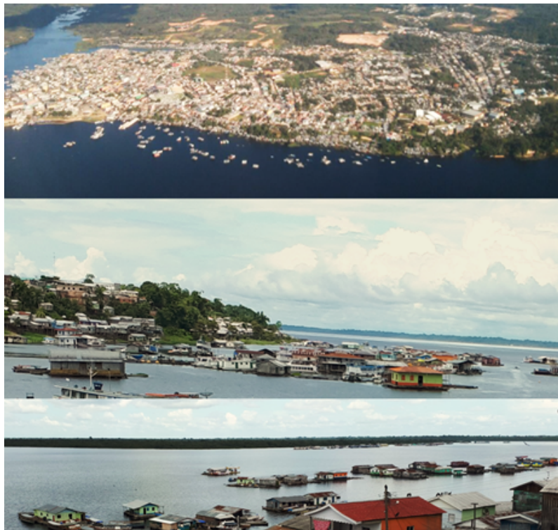
Figura 12 – Flutuantes do Núcleo secundário do bairro Juruá
