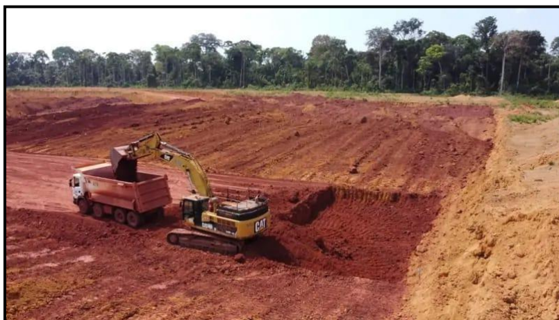
Figura 2: Processo de Extração do Minério
