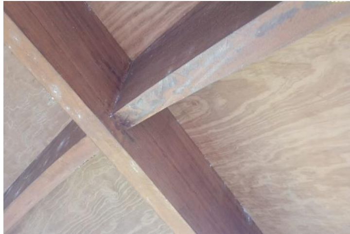
Figura 3 - Resolução de problemas/ encaixes das vigas
