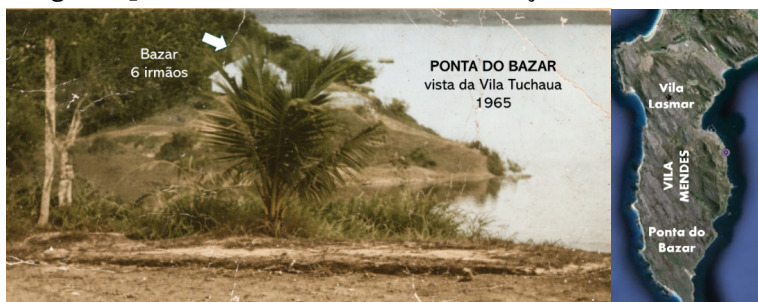
Figura 24 – Ponta do Bazar antes da construção da Vila Mendes
