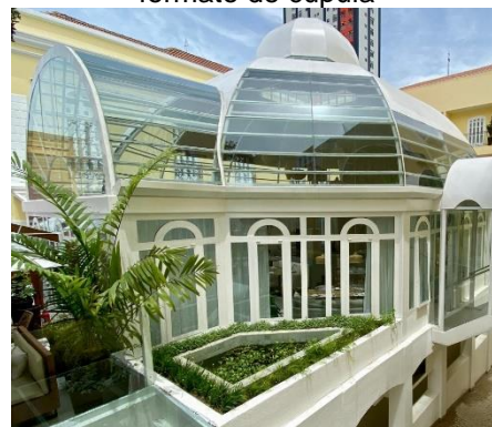
Imagem 14 – Estrutura do restaurante em formato de cúpula
