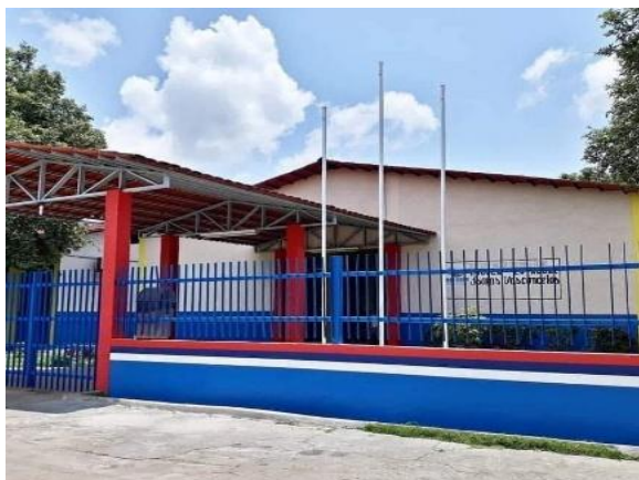
Figura 3 - Imagem atual da Escola Isaías Vasconcelos
