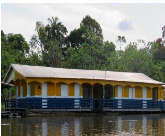
Figura 22 - Imagem da Escola Flutuante antes da reforma
