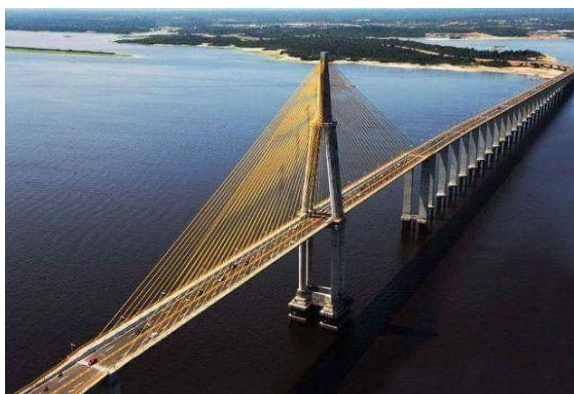
Figura 7 - Imagem da ponte sobre o Rio Negro
