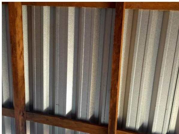
Figura 2 – Fotografia do telhado construído
