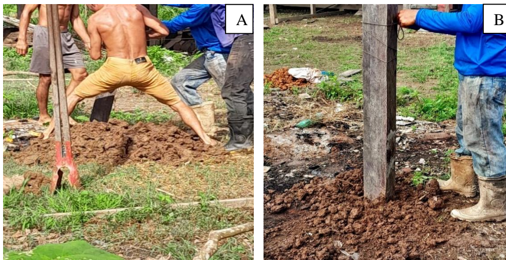
Figura 1a, 1b – Fotografias da fixação de um esteio sendo erguido
