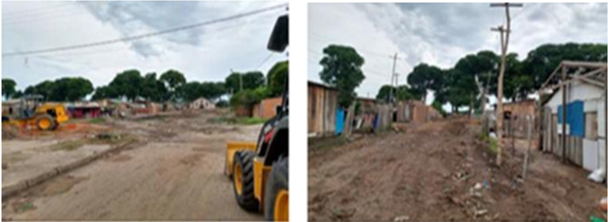
Figura 2 e 3: Área do Castanhal e os problemas ambientais decorrentes da ocupação irregular
