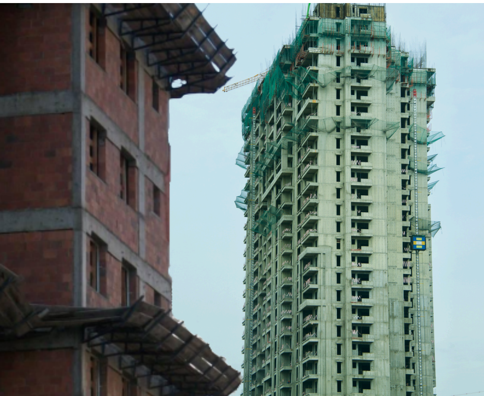
Foto: Em primeiro plano, o prédio usou de bandejas para evitar a queda de materiais e em segundo plano, prédio utilizou andaime fachadeiro para evitar a queda de pessoas e de materiais.
