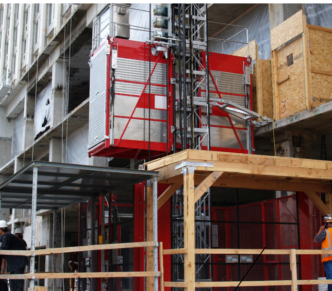
FECHAMENTO DA BASE DA TORRE PROTEÇÃO PERIFÉRICA
