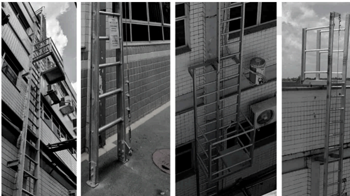
Foto: Escada projetada e instalada pela equipe da Ranger SMS, em conformidade com a nova NR 18 de fevereiro de 2020. Fonte da imagem: Grupo Ranger SMS
