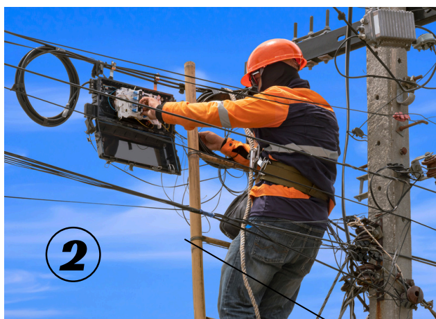
Foto: Seleção de uma escada constituída de material isolante (resistente a passagem de corrente elétrica).
