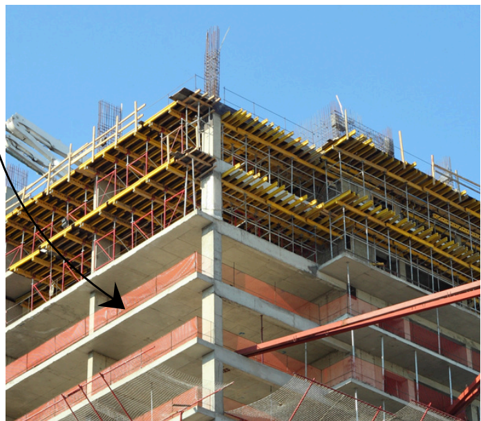
Foto: Prédio utilizou rede uniforme, com material resistente, capaz de evitar a queda de pessoas e de materiais.
