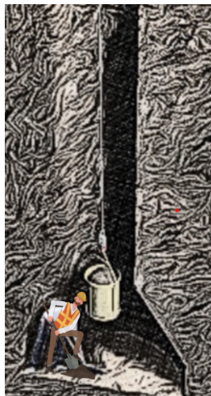
Foto: Escavação manual sendo realizada em solo estável.
