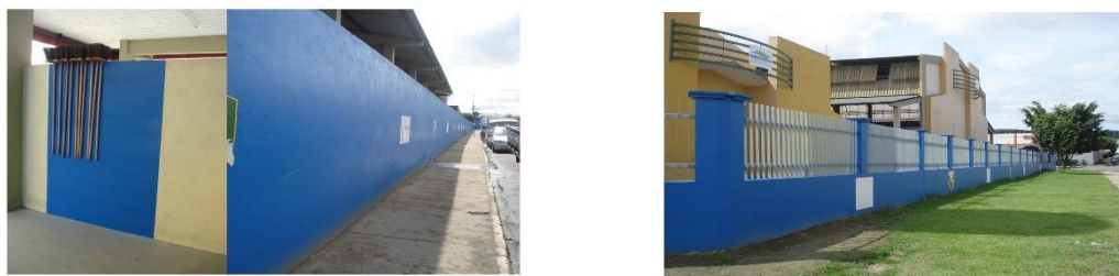
Foto 6 – Restauração da pintura dos muros
