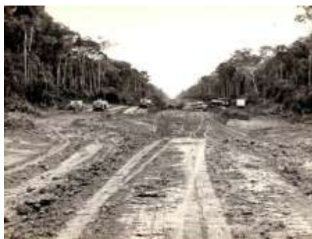
Figura 2 – Construção da BR-319 – 1972. Fonte: OBR-319 (2025).
