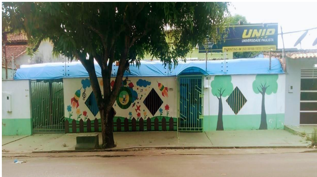
Figura 2: Centro de Educação Ilha do Saber no Município de Parintins
