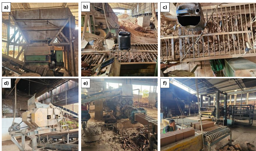
Figura 2. Processo de confecção do tijolo (Olaria A) – a) Alimentador; b) Misturador; c) Misturador - visão de cima; d) Laminador; e) Maromba a vácuo; e f) Fatiador automático.
