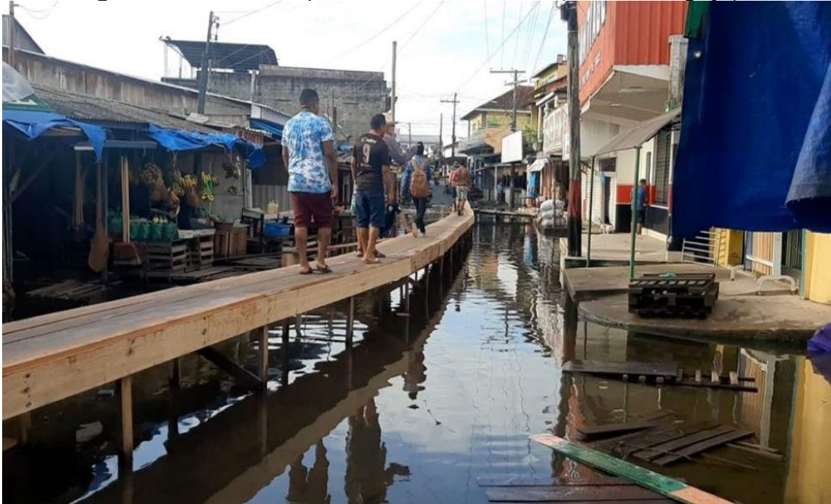
Figura 3: Passarela improvisada na Rua Silves (Feira do Bagaço).
