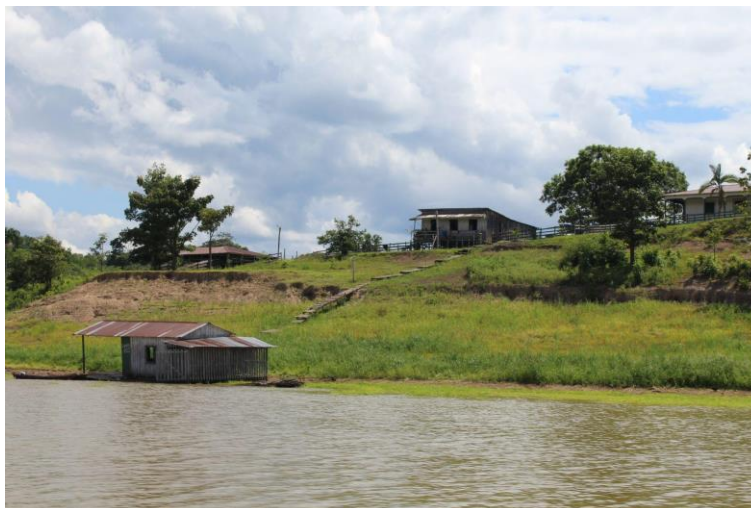
Fotografia 3 - Casa flutuante e palafitas no beiradão, interior de Manacapuru.
