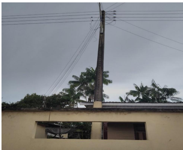
Figura 7. Vista de poste em quintais de casas no bairro Eduardo Braga
