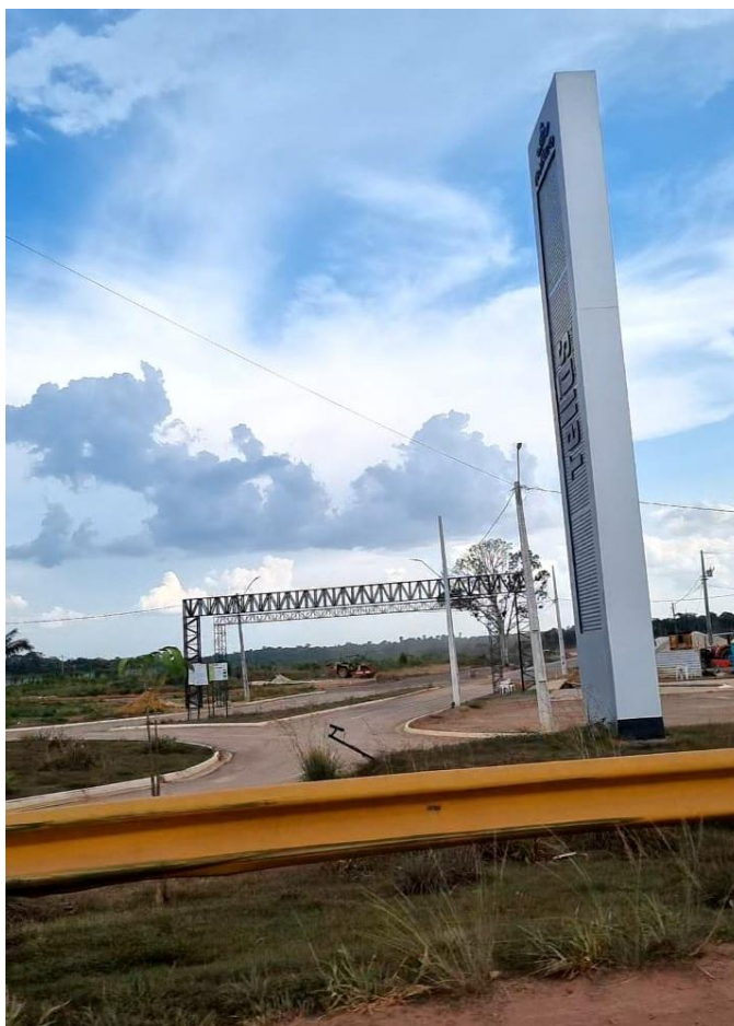
Figura 47: Construção de empreendimento imobiliário (KM 6 – AM 0-70). Fonte: A autora, 2024.
