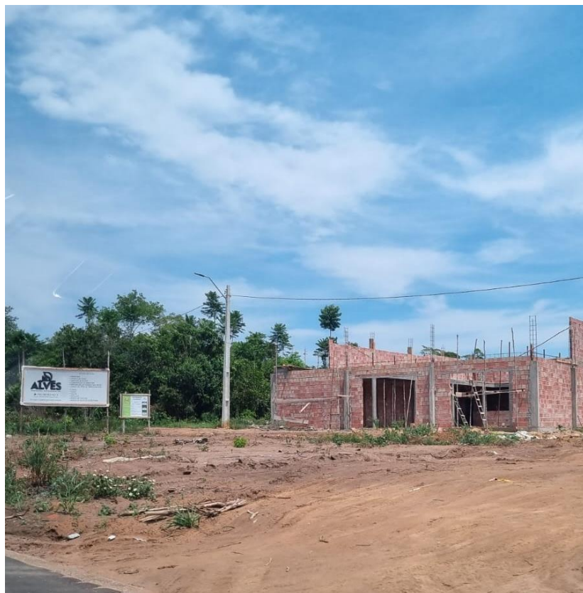
Figura 52: Construções na AM 0-70. Fonte: A autora, 2024.
