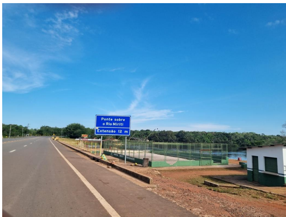
Figura 40: Ponte sobre o Rio Miriti (KM 76). Fonte: A autora, 2024.
