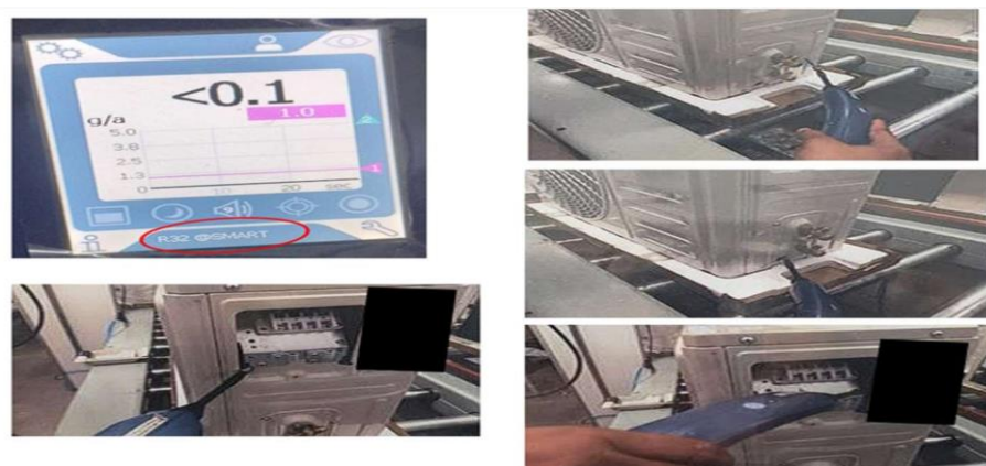
Figura 26 - Atividade realizada no posto de teste de vazamento 2
