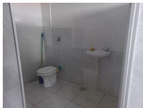
Figura 13 - Banheiro Feminino prédio 2
