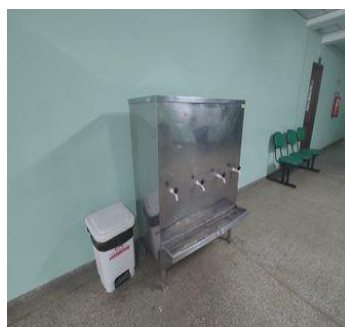
Figura 9 - Bebedouro do prédio 2
