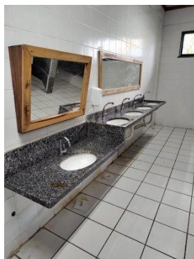
Figura 12 - Banheiro Feminino prédio 1
