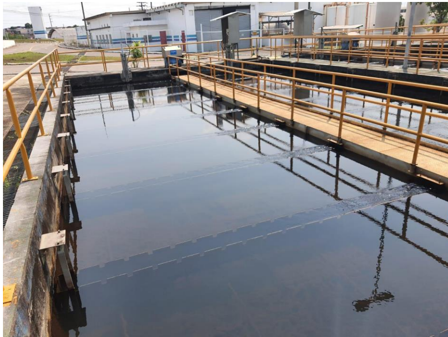
Figura 9- Decantador em uma estação de tratamento de água.
