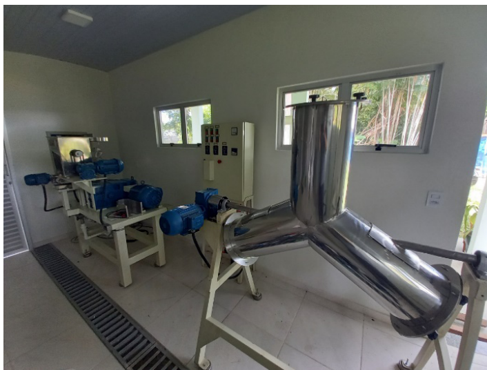
Figura 5 - Vista interna da Fábrica de Ração Demonstrativa
