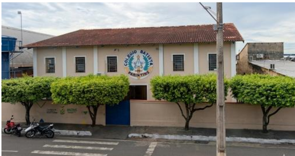
Figura 1: Fachada do Colégio Batista de Parintins, localizado no centro da cidade de Parintins, Amazonas.
