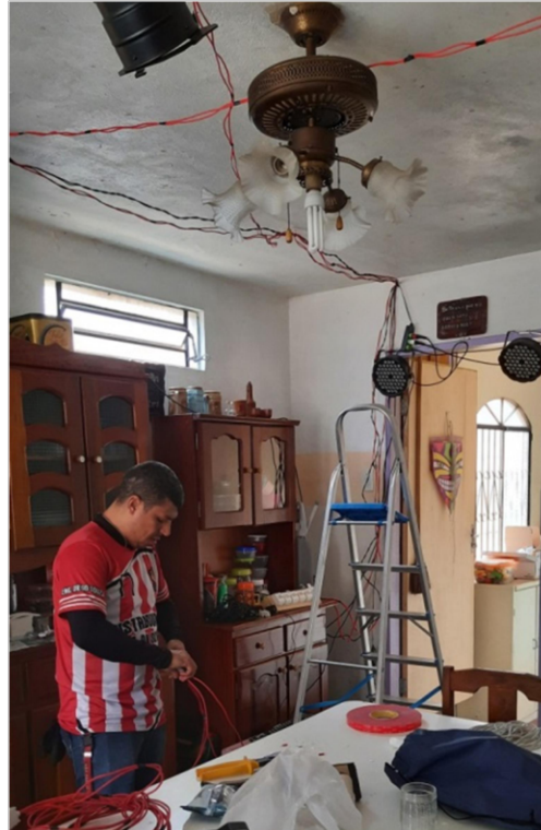
Fig. 18. Manoel Messias conectando os cabos elétricos Fonte: Arquivo pessoal, 2022
