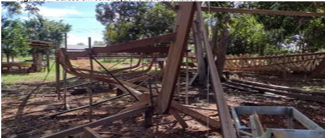
Figura 5 - Barcos em construção no Estaleiro Itaúba
