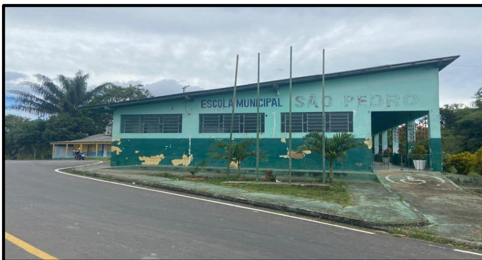
Figura 1 – Escola Municipal São Pedro
