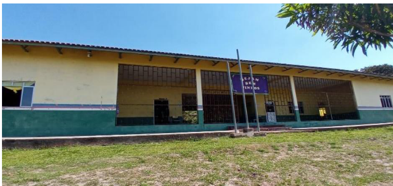
Figura 1 - Escola Municipal São João do Miriti, localizada na área rural do município de Alvarães
