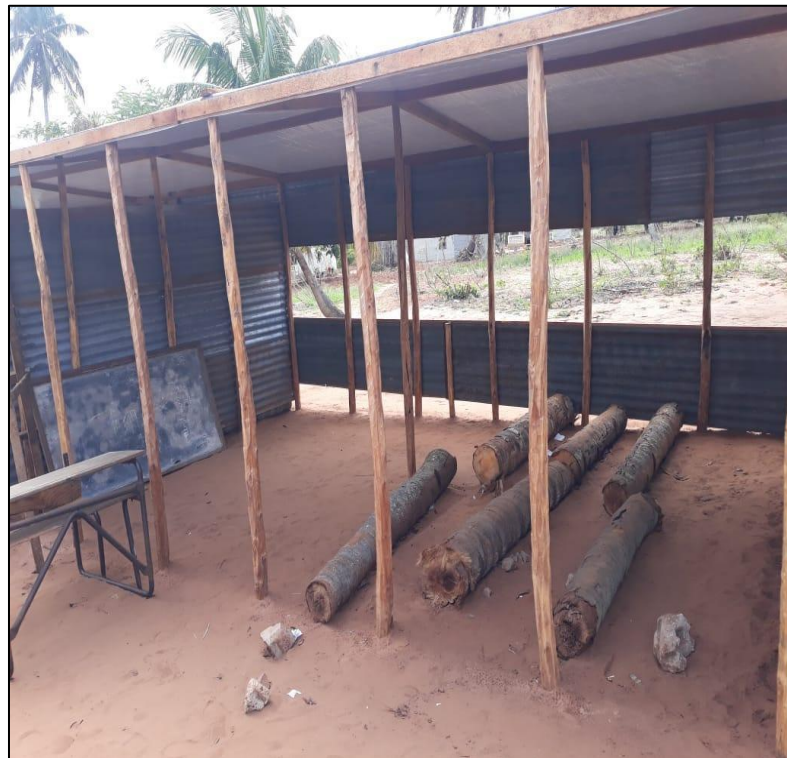
Figura 4: Sala de aulas de um bairro da periferia, em Moçambique
