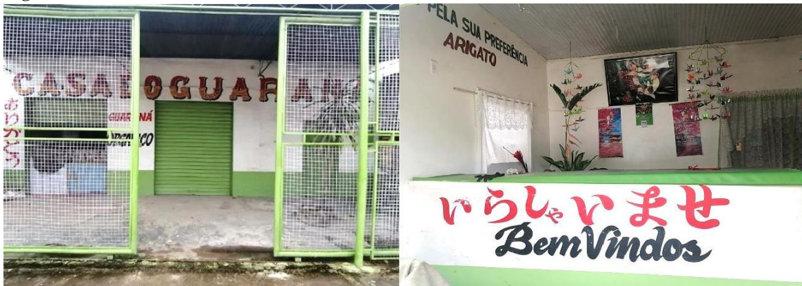
Figura 04: Estrutura da Casa do Guaraná.
