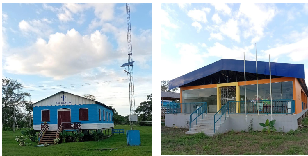
Figura 1: aspectos arquitetônicos da parte frontal da comunidade
